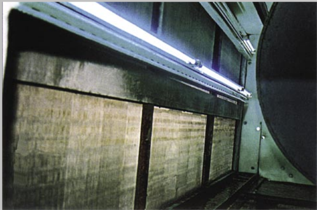
Emissores de UVC em ação numa serpentina
